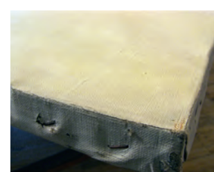
Fig. 3. Los marcos y molduras sin protección son ocasión de roces y pérdidas en los bordes de la pintura.
