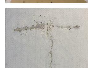
Fig. 8. Detalle del desgarramiento después de la colocación de injertos y del refuerzo del reverso.
