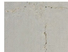
Fig. 3. La eliminación del repinte evidencia la necesidad de intervenir desde el reverso para reforzar la tela desgarrada.
