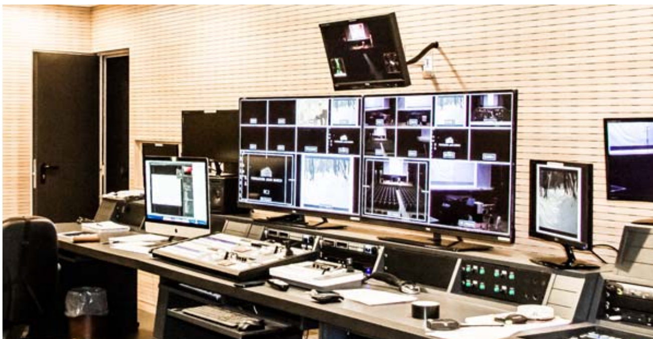
Sala de control de la Fundación Juan March
