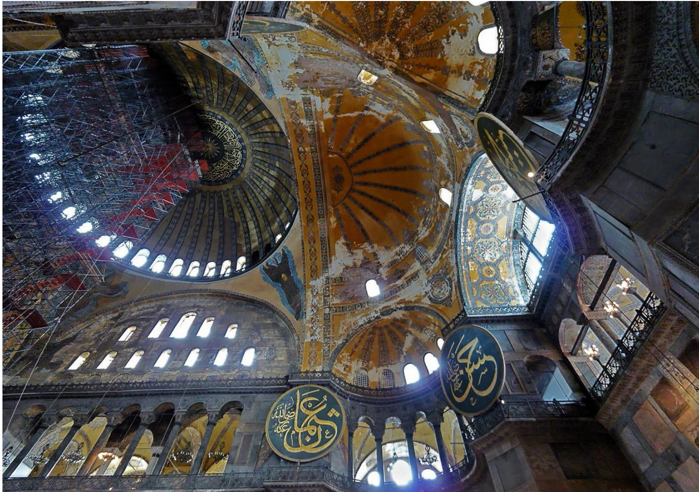
Conjunto de bóveda, galería, exedra y semicúpulas
