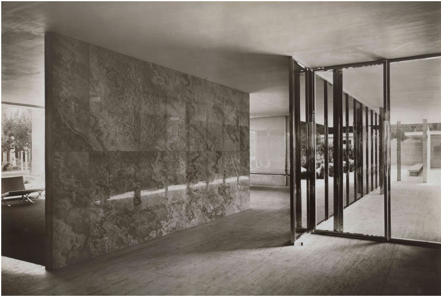
Mies van der Rohe . Pabellón de Barcelona. Salida lateral con puertas de vidrio temporales
